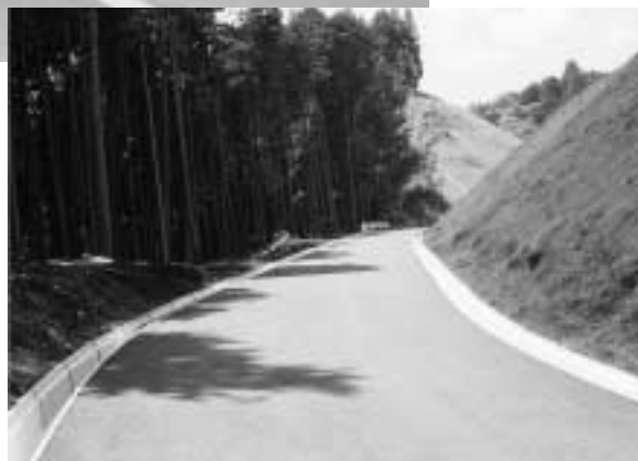
道路改良工事
