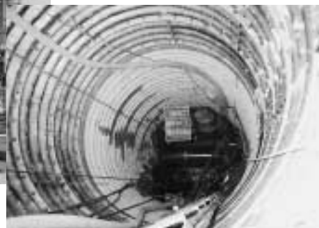
下水道管埋設工事
