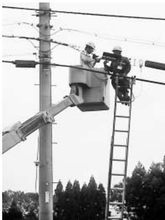
ケーブルテレビの工事
