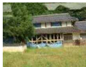
▲放置された民家
