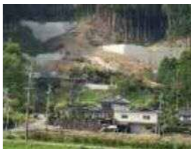
▲裏山の復旧工事
