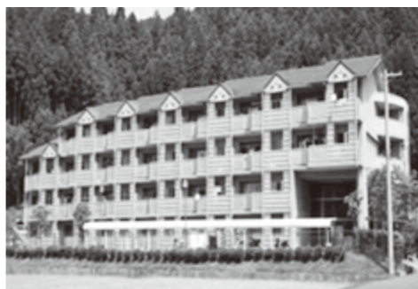
▲公営住宅 笠神団地
