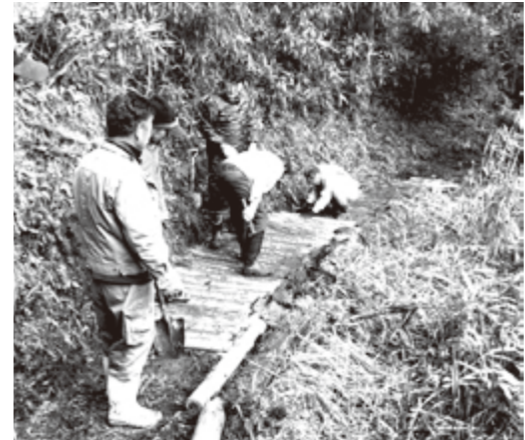
▲伊勢街道の補修作業中
