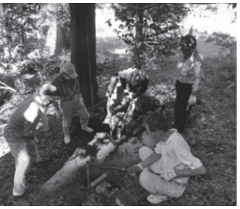
▲案内板設置作業
