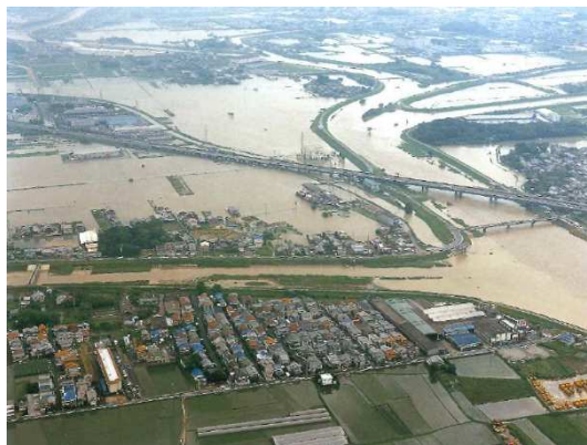
⑤河合町 昭和57年8月2日 近畿地方整備局 大和川河川事務所提供
