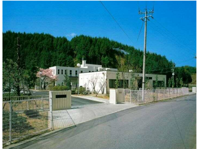
写真 し尿処理を担う宇陀衛生センター
