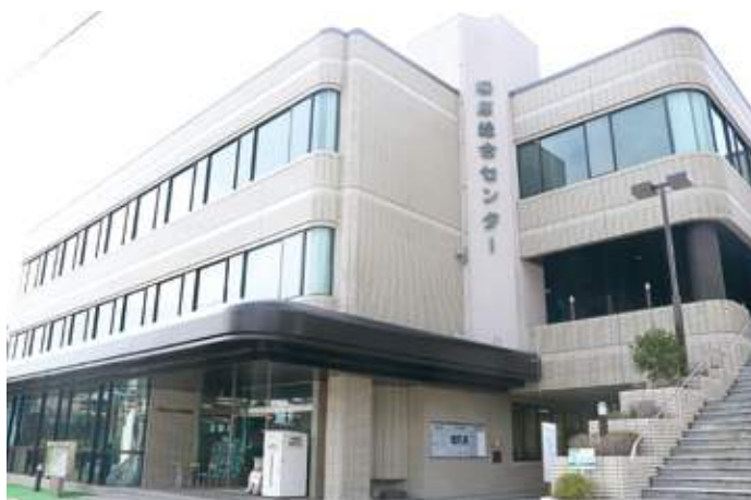
写真 リニューアルした榛原総合センター
