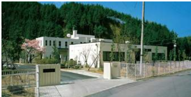
写真 し尿処理を担う宇陀衛生センター
