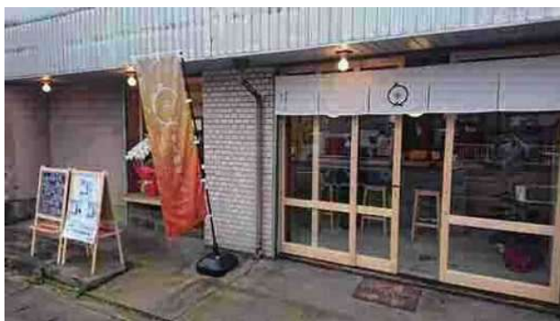
空き家を改修し起業
