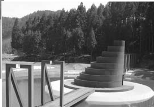
北緯34度32分の軸線上「太陽の道」に建つ太陽の塔
