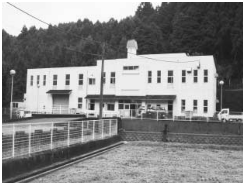
宇陀衛生センター
