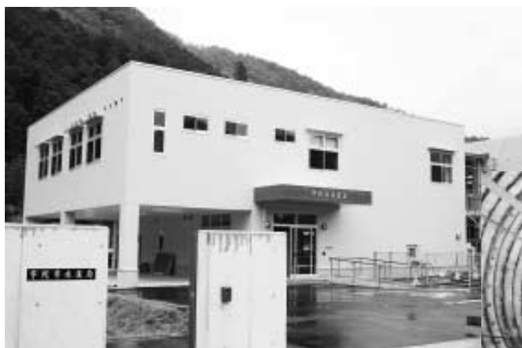
水道局舎増築
