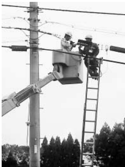
ケーブルテレビの工事
