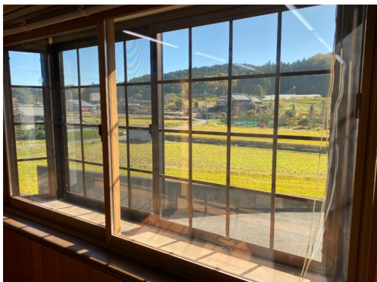
(写真) 窓断熱リフォームの一種の二重窓
